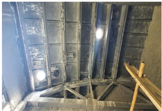
ავტოკლავირების ოთახის ჭერი (რკინა-ბეტონის კონსტრუქცია)
