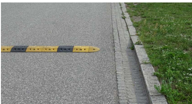
ილუსტრაცია 5-10: სიჩქარის შემზღუდველი ბარიერების გაცილებით ველომეგობრული დიზაინი. (ფოტოს ავტორი: მიჰაელ ჰაასე)
