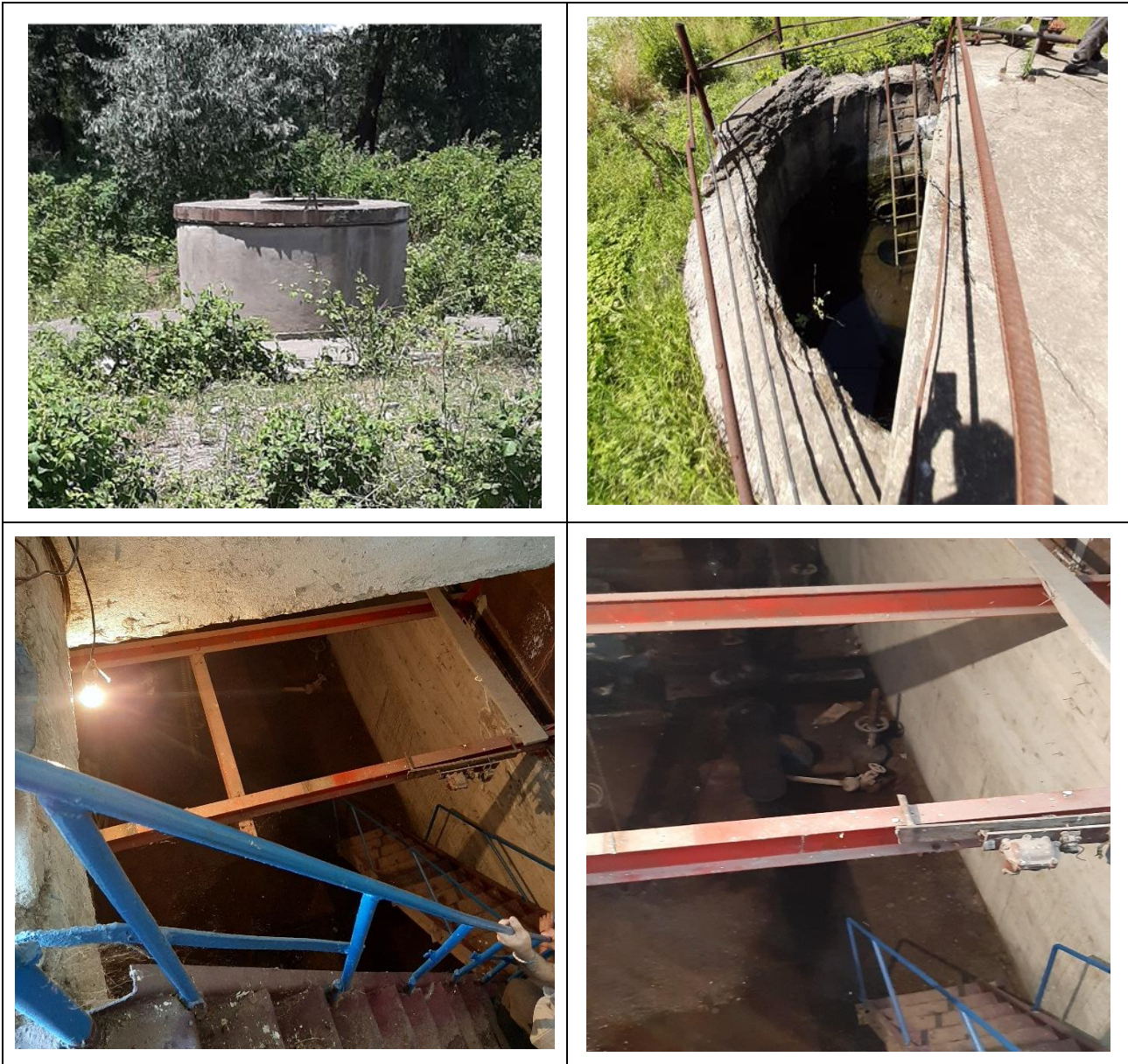
სურათი 4.10.1. ფილტრატის შემკრები ჭები, რეზერვუარი და მიწისქვეშა სატუმბო სადგური
