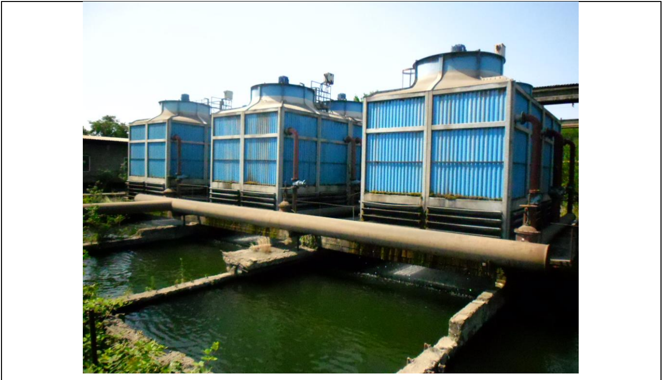
სურათი 4.10.3. საწარმოში არსებული შხეფმაცივრები
